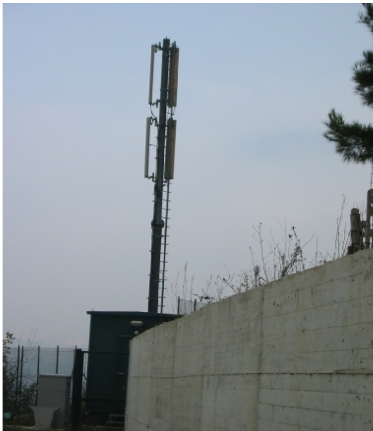
Tipologia: antenne per telefonia cellulare Gestore: Tim Sistema: GSM 900
